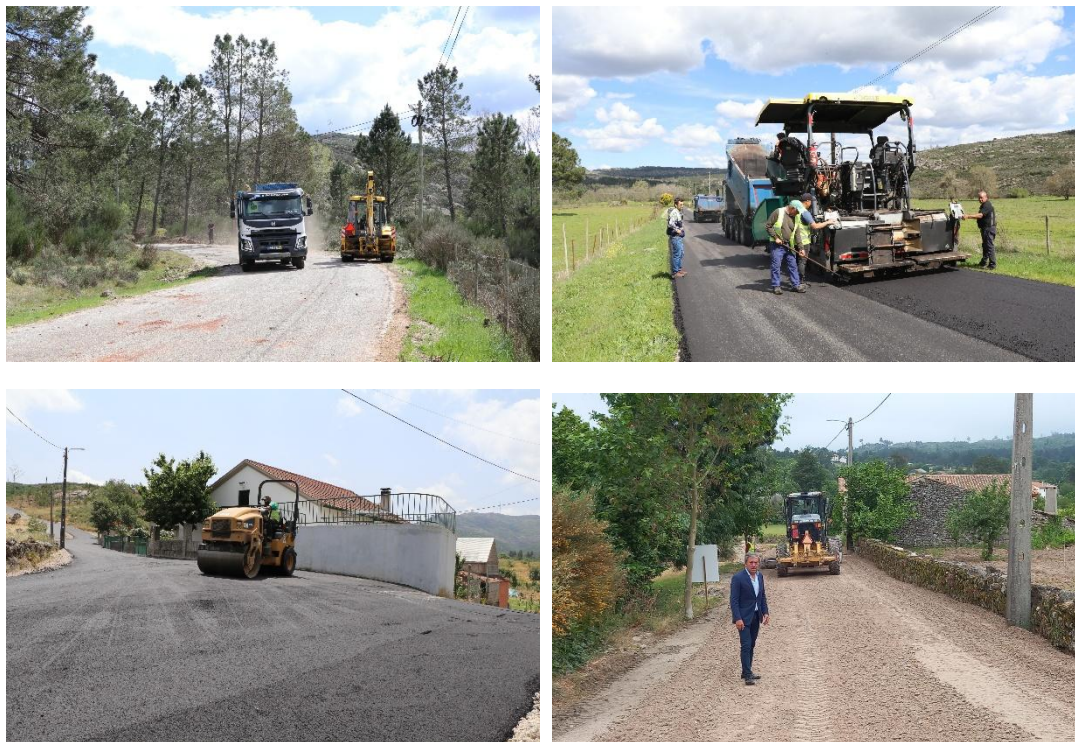
Figura 12. Reparação e Beneficiação de Diversas Estradas e Caminhos.
