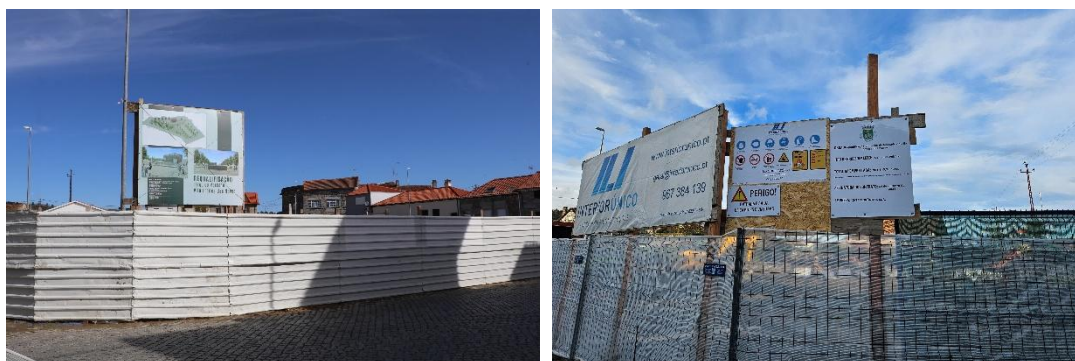
Figura 11. Requalificação do Largo do Mercado em Vila Franca das Naves.
